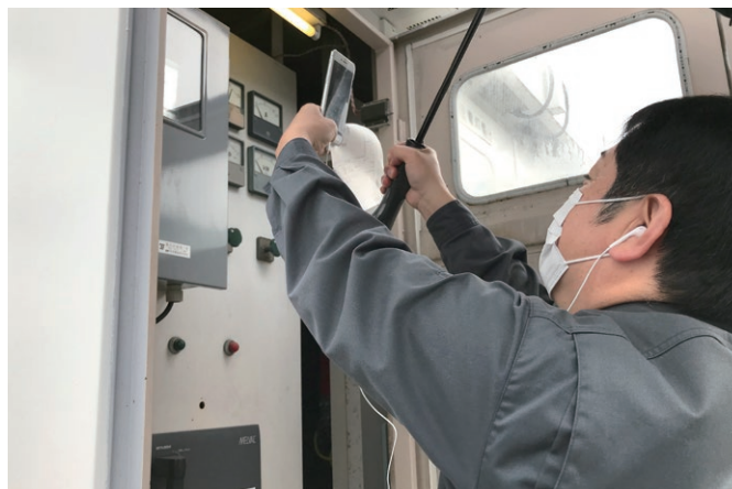
リモート検査のため、メーター数字をスマートフォンでアップ
