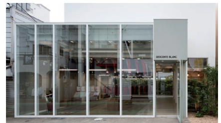
「DESCENTE BLANC 福岡」の外観
