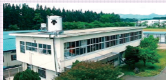
再生可能エネルギー由来の電力供給に切り替えた水沢工場
